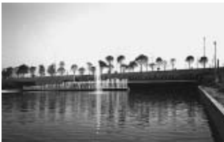
Dipòsit de retenció a l'aire lliure
